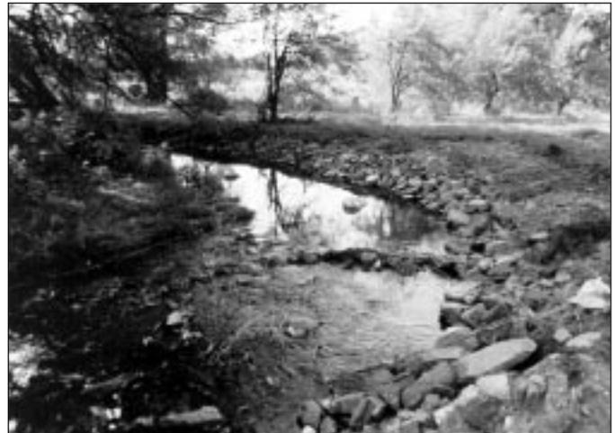
Des déflecteurs installés dans des ruisseaux permettent de concentrer ou de réorienter le débit de l'eau afin de réaménager les cours d'eau à méandres.
